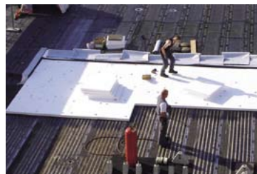
写真 5 OWIの屋根の断熱化
