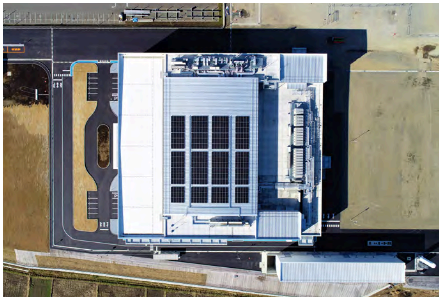
写真中央は屋根に設置した太陽光パネル（総発電容量180kW）
